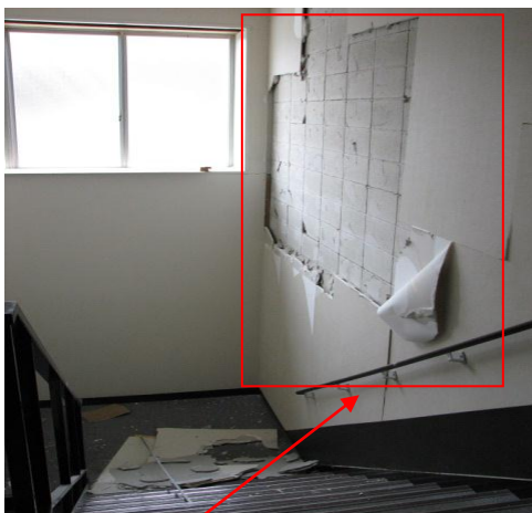
階段の脇の壁崩落
